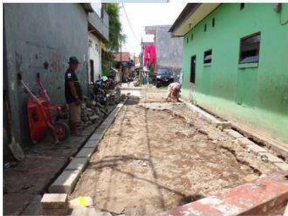
Gambar 5. Perbaikan Jaringan Jalan dan Drainase di Kelurahan Lette
