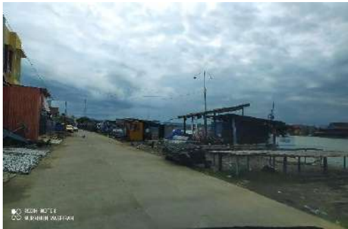
Gambar 3. Kondisi Jalan dengan kontruksi beton
