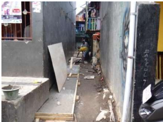
Gambar 7. Perbaikan Jaringan Jalan di Kelurahan Lette
