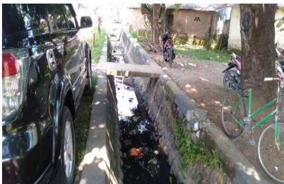
Gambar 5. Kondisi Eksisting Jaringan Drainase Desa Kanjillo
