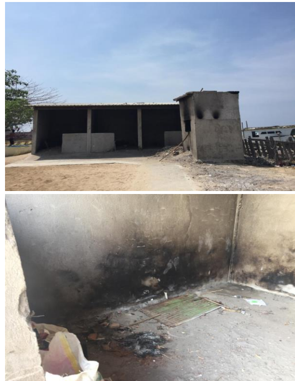
Gambar 3. Bangunan pemilahan sampah
