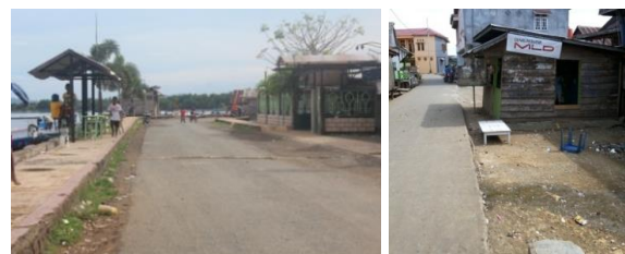
Gambar 11. Jalan tanpa saluran drainas
