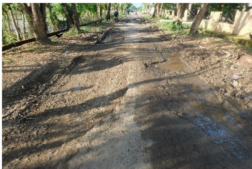
Gambar 4. Kondisi Jalan dengan konstruksi tanah
