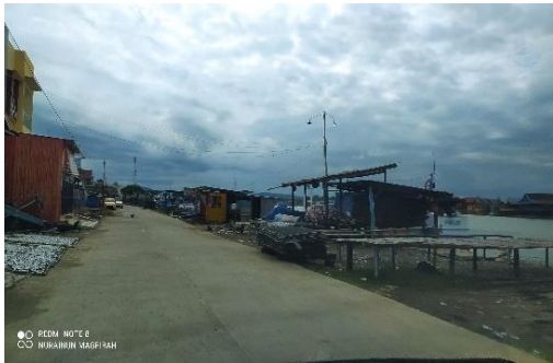
Gambar 3. Kondisi Jalan dengan konstruksi beton
