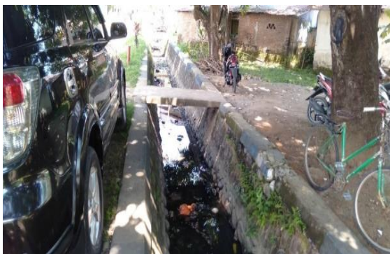
Gambar 5. Kondisi Eksisting Jaringan Drainase Desa Kanjillo
