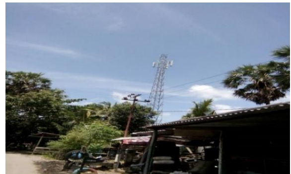
Gambar 7. Kondisi Eksisting jaringan BTS Desa Kanjillo
