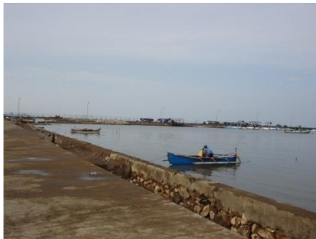
Gambar 4. Kondisi jalan di depan TPI tempat penambatan perahu nelayan
