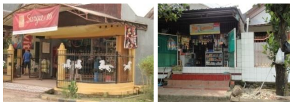
Gambar 4. Kios yang terdapat di Perumahan Taman Telkomas
