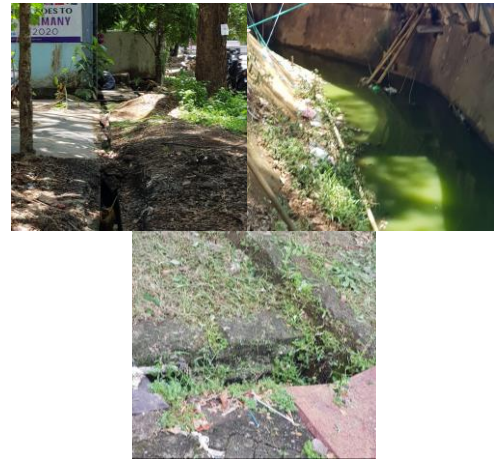
Gambar 9. Kondisi eksisting permasalahan drainase Kawasan Unhas Tamalanrea
