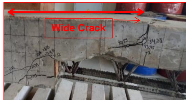
Gambar 9. Pola retak balok BTRP 40D
