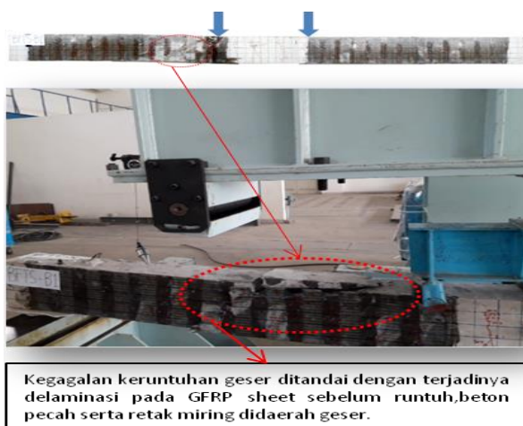
Gambar 13. Mode keruntuhan balok BFTS
