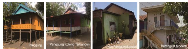
Gambar 3. Bentuk konstruksi bangunan di pesisir pantai tanjung bayang
