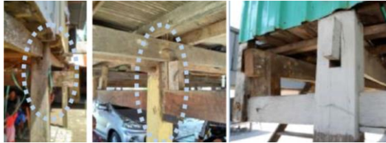
Gambar 5. Ilustrasi foto konstruksi tiang kolong dan balok penyangga lantai rumah panggung di pesisir pantai tanjung bayang
