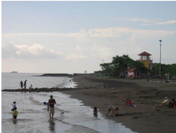
Gambar 1. Suatu senja di Pantai Akkarena, Tanjung Bunga. Tampak konstruksi groin yang sudah hancur dan pantai yang sudah tergerus gelombang, sementara baik anak-anak maupun orang dewasa tetap menggunakan lokasi tersebut untuk rekreasi.
