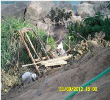
Fig.14a. Drill bore hole D120mm
