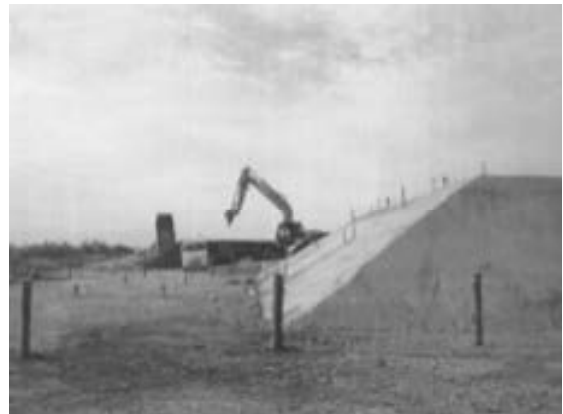
(d) Constructing new embankment
